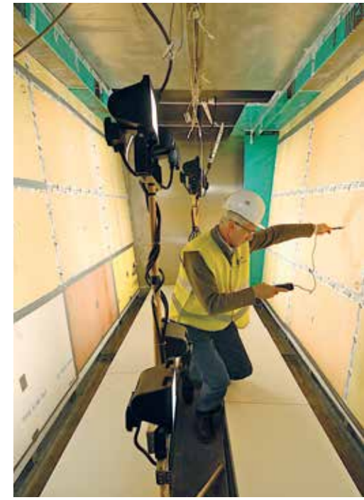
I test condotti nel centro di ricerca Etex ad Avignone
